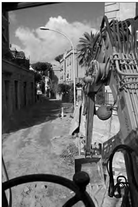
I lavori di riqualificazione del tratto di Via della Sette Chiese.
