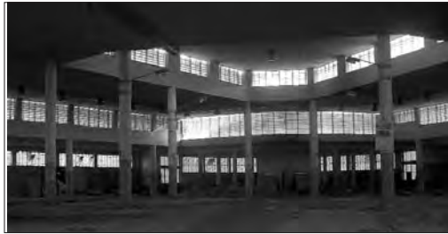
Il completo stato di abbandono in cui versa il mercato
