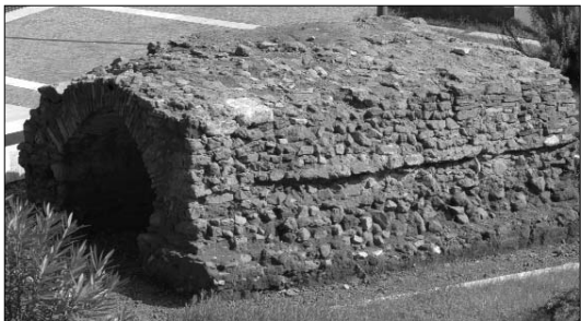
Il ponticello di Piazza Biffi nella posizione attuale. Sulla destra le foto al momento del ritrovamento e mentre viene innalzato al livello della Piazza
