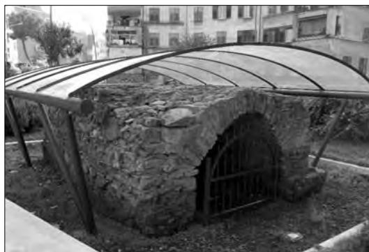
Come appare adesso il ponticello di Piazza Biffi dopo la tanto attesa copertura
