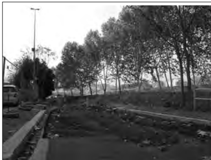
Il tratto di Via Palos interrotto dai lavori
