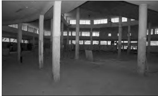
L'interno del mercato coperto della Garbatella come si presenta attualmente
