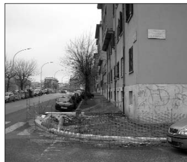
Rifacimento dei marciapiedi in Piazza O. da Pordenone
