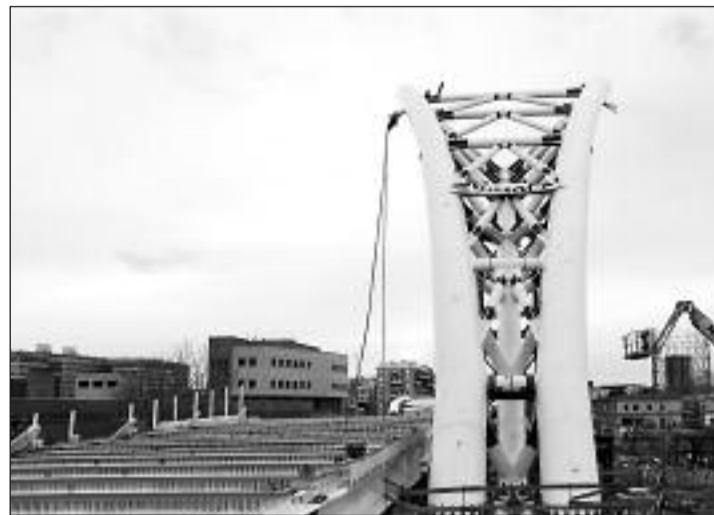
Il ponte in costruzione
