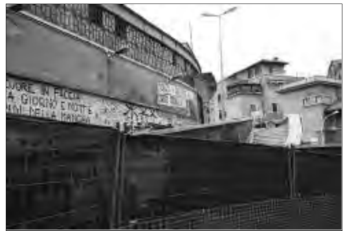
Un'immagine che dimostra la ripresa dei lavori al mercato "Coperto"
