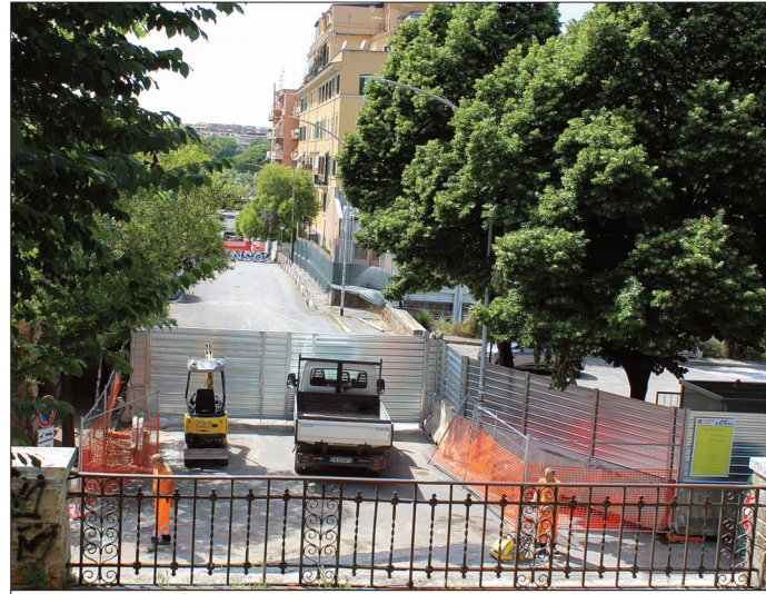
Lavori a via Giulio Rocco Foto di Alessia Samaritani
