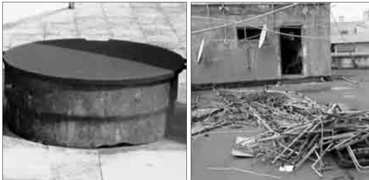
A sinistra un serbatoio in amianto ancora presente sulla terrazza dell'Albergo Bianco. A destra lo stato di abbandono di uno spazio comune condominiale (Foto di Simone Bartolucci)
