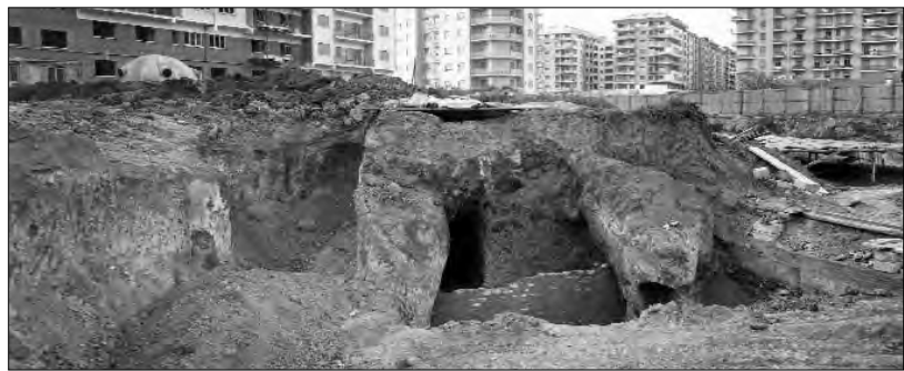
Ecco come si presentavano nel 1961 le gallerie della catacomba, devastate dallo scavo per la costruzione dell'edificio di Via Silvio D'Amico 40.
