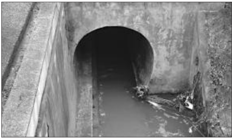
Il Fiume Almone all'ingresso del condotto sotterraneo all'interno del Parco Scott
